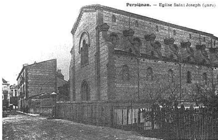
Rue Cabrit — L'église Saint-Joseph vient d'être construite. La chaussée n'est pas encore goudronnée.
