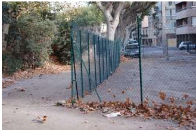
↑ Travaux en cours
