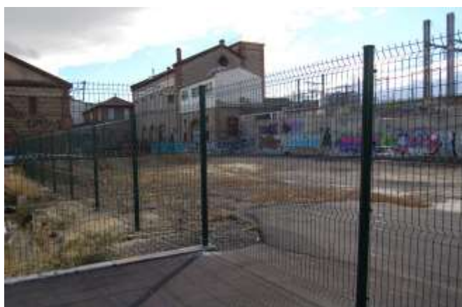
↑ Nettoyage au niveau des anciens entrepôts Quinta, et sécurisation du site.
