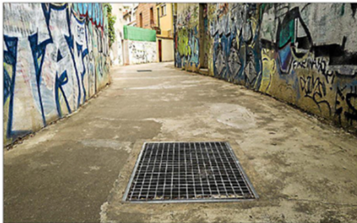
Le canal des quatre cazals est situé sous le passage du même nom, parallèle à l'avenue de la Gare. N. PAVENT
